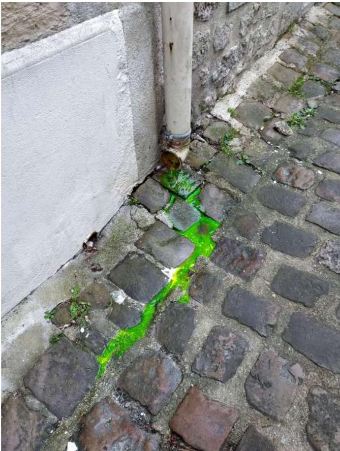
Figure 3. Test au colorant : Le regard de branchement « RFU ».
