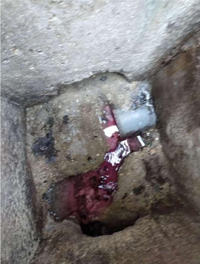
Figure 4. Test au colorant : Le regard de branchement « RFU ».
