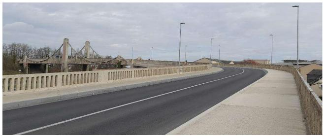
La première phase des travaux d'avril à octobre 2022 a permis la réfection des superstructures et de l'étanchéité de l'ouvrage avec la reconstruction de la chaussée, des trottoirs et création d'une piste cyclable.
