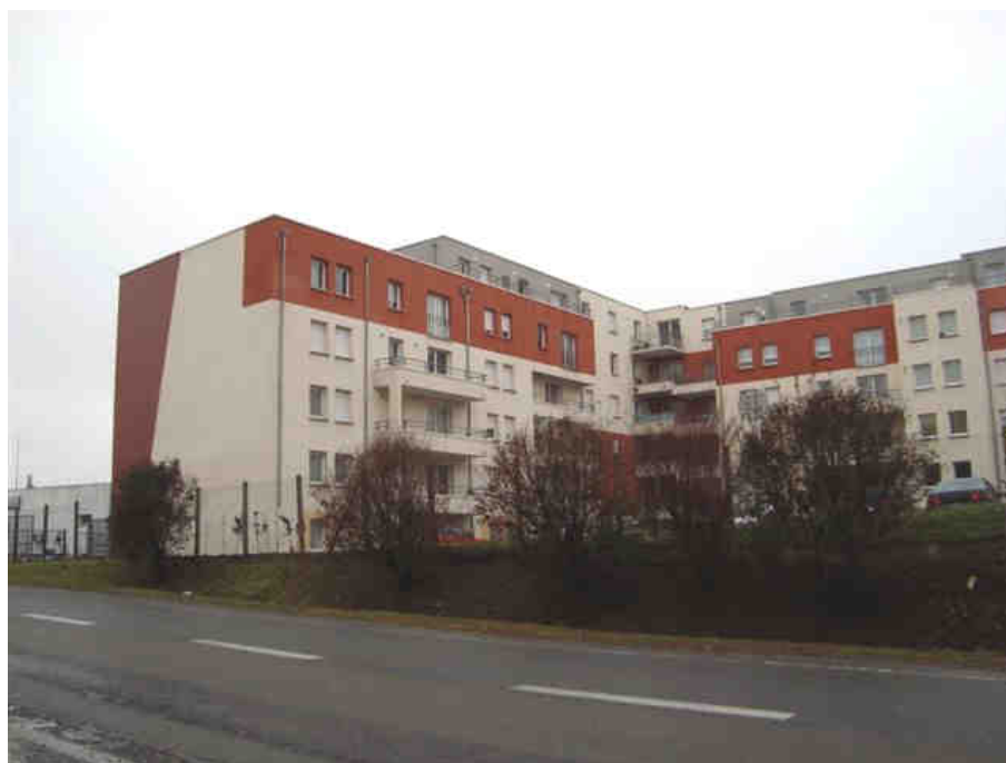
Fiche 4 : bâtiment d'habitation construit en 2009
