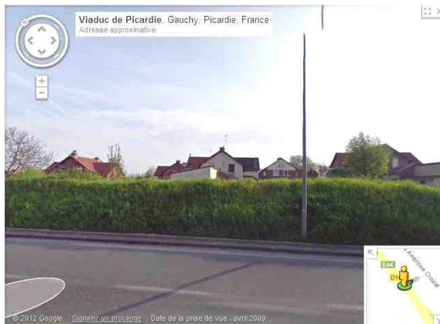
Fiche 16 : habitation mitoyenne construite avant 1978
