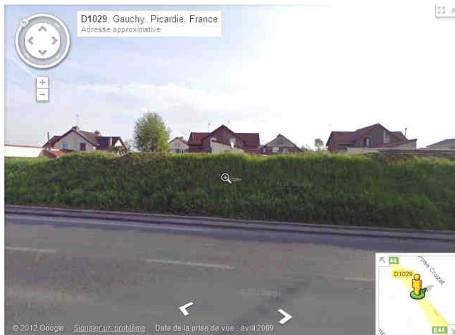
Fiche 17 : habitation mitoyenne construite avant 1978
