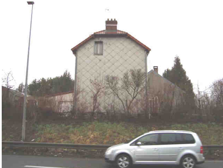
Fiche 23 : 2 bâtiments d'habitation antérieurs à 1978
