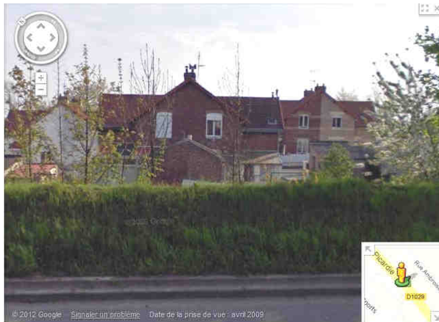
Fiche 14 : habitation mitoyenne construite avant 1978
