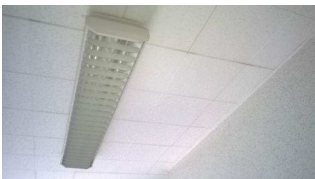
P 3: Bâtiment - R+1 - 20 - Faux-plafond plaque 30x30 - Photo n° 3
