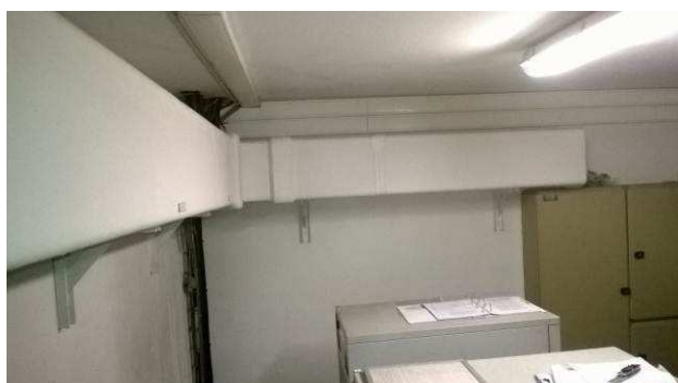
IV : Bâtiment - R-3 - 87 - Gainage de ventilation haute - Photo n° 11
