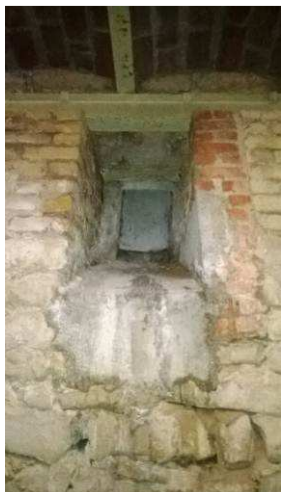
IV : Bâtiment - R-2 - 60 - Gains de ventilation basse - Photo n° 13
